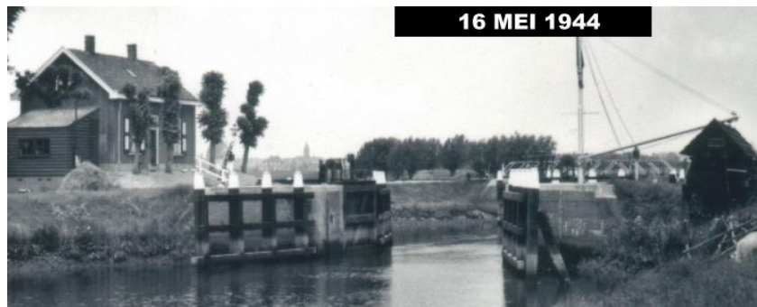
Helsluis in de Biesbosch bij Werkendam
